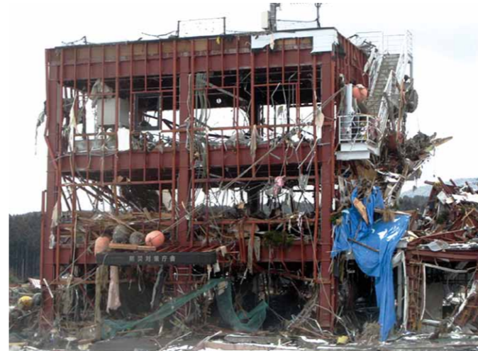
津波で被災した南三陸町(宮城県)の防災対策庁舎
